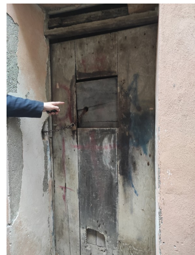
Frinèstron per susvelhar los Valdés a l'interior de las maisons.
